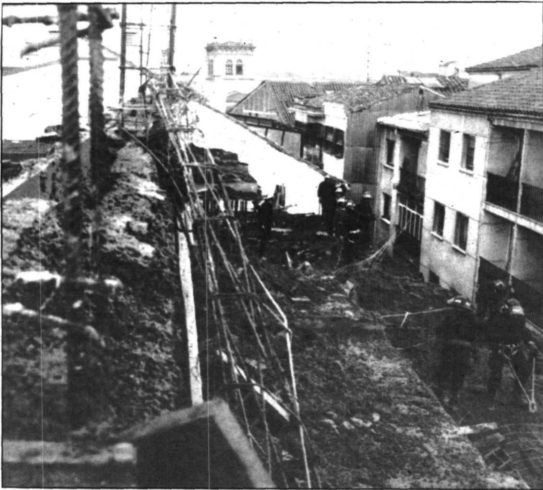
El derrumbamiento de un encofrado de hormigón en la cuarta planta de un piso en construcción ocasionó el trágico siniestro. (FOTOS WIFREDO)
