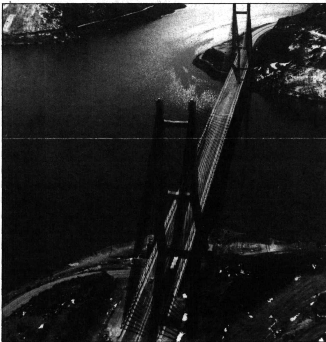
La construcción de la autopista León-Asturias ha sido una de las obras de ingeniería más importante que se ha acometido en la Comunidad.
