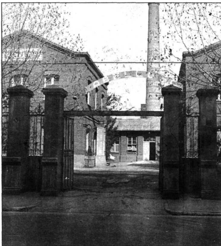
Instalaciones de la fábrica de Antibióticos Abelló.
