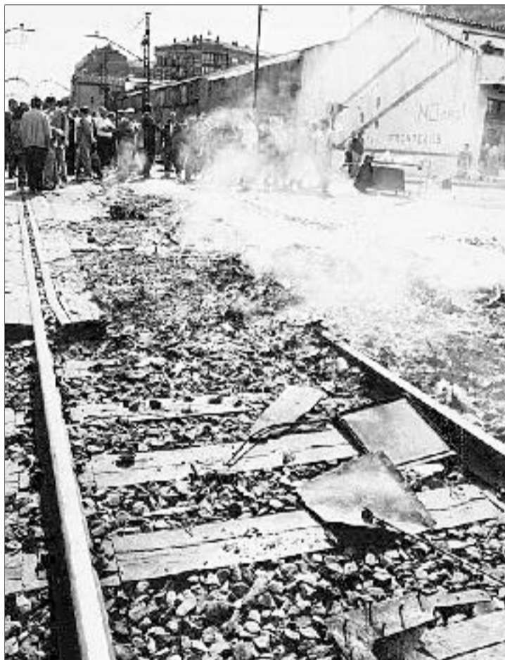
Los daños en las vías impidieron la circulación de trenes. FOTO EFE
