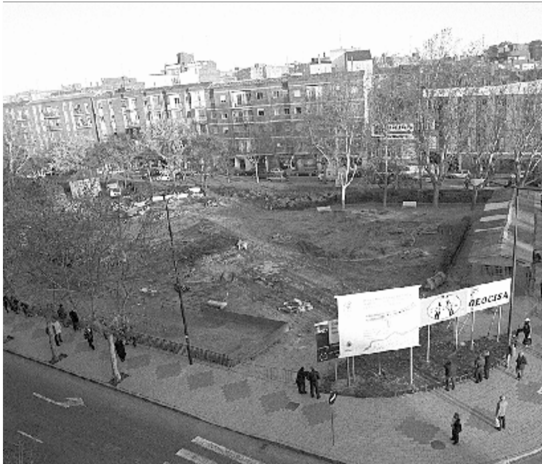
Aspecto que ofrecían ayer los jardines de La Rubia tras la paralización de las obras. FOTO H. SASTRE
