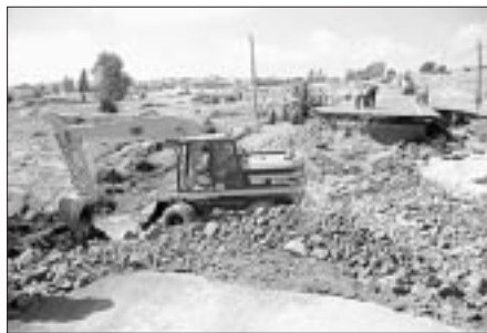
Las máquinas reparan los destrozos.
