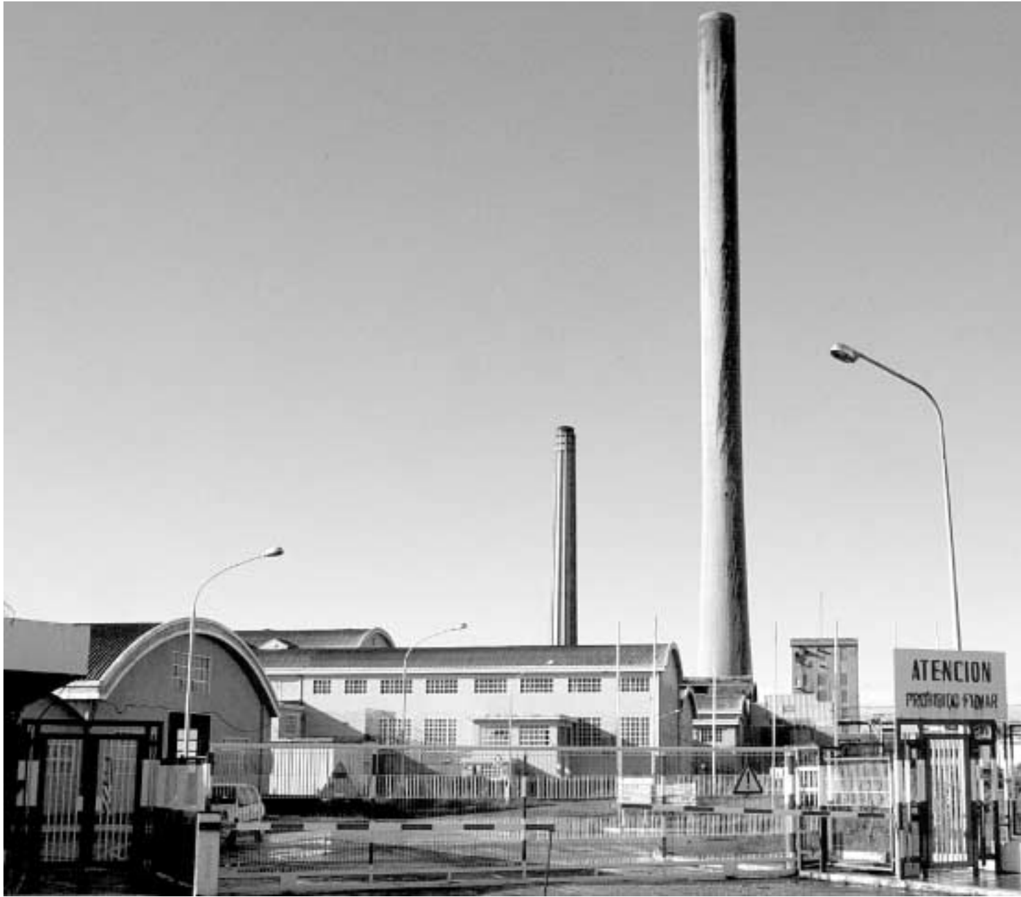
La chimenea de la Cellophane, que será derribada para construir viviendas en la capital burgalesa.
