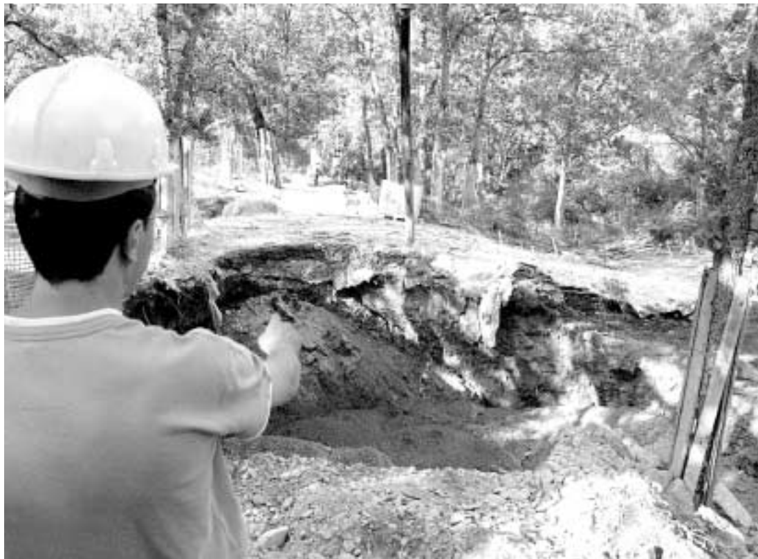
Uno de los responsables señala el agujero provocado por la tuneladora. / J. MARTÍN-EFE
