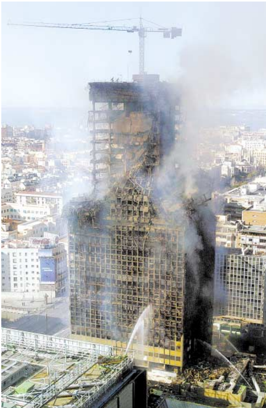
Vista área del corazón financiero de Madrid con el edificio Windsor arrasado por el fuego. / P. CAMPOS-EFE
