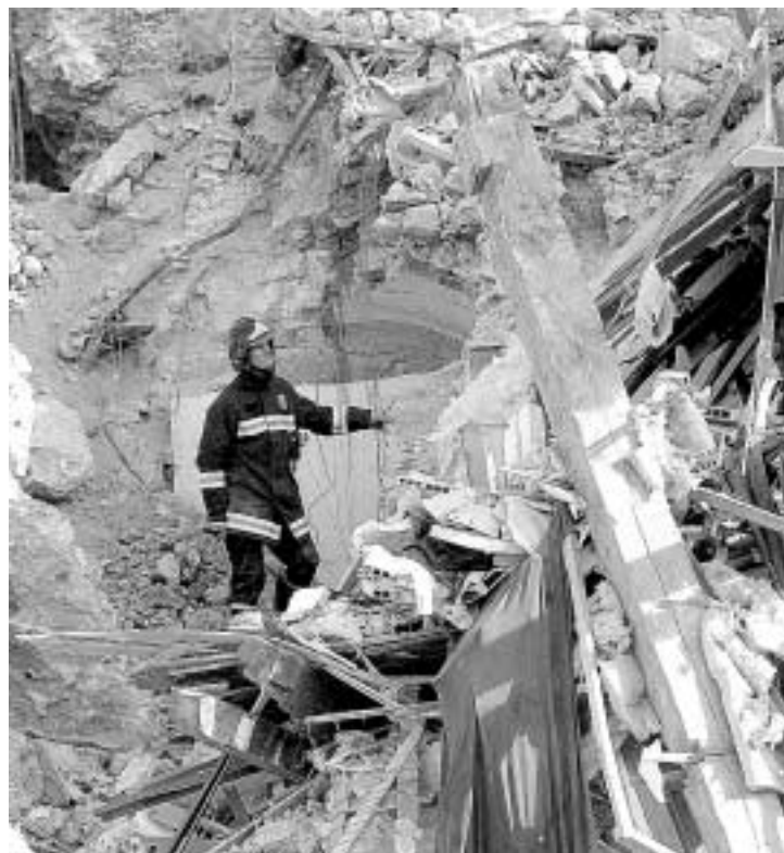
Un bombero trabaja entre los escombros del edificio. / ANTONIO DE TORRE
