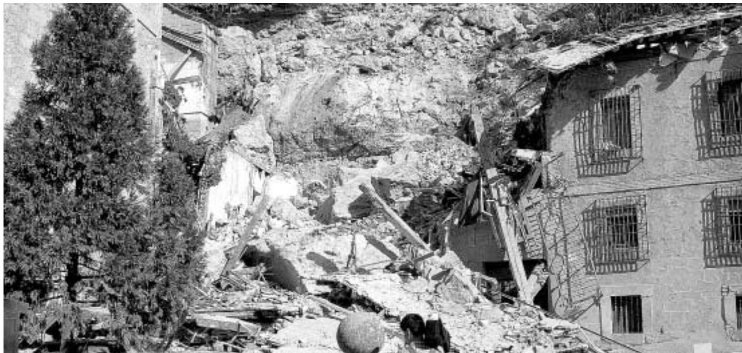
Vista general de la zona de derrumbe y de los restos del edificio de la casa rectoral del Santuario de La Fuencisla. / ANTONIO DE TORRE
