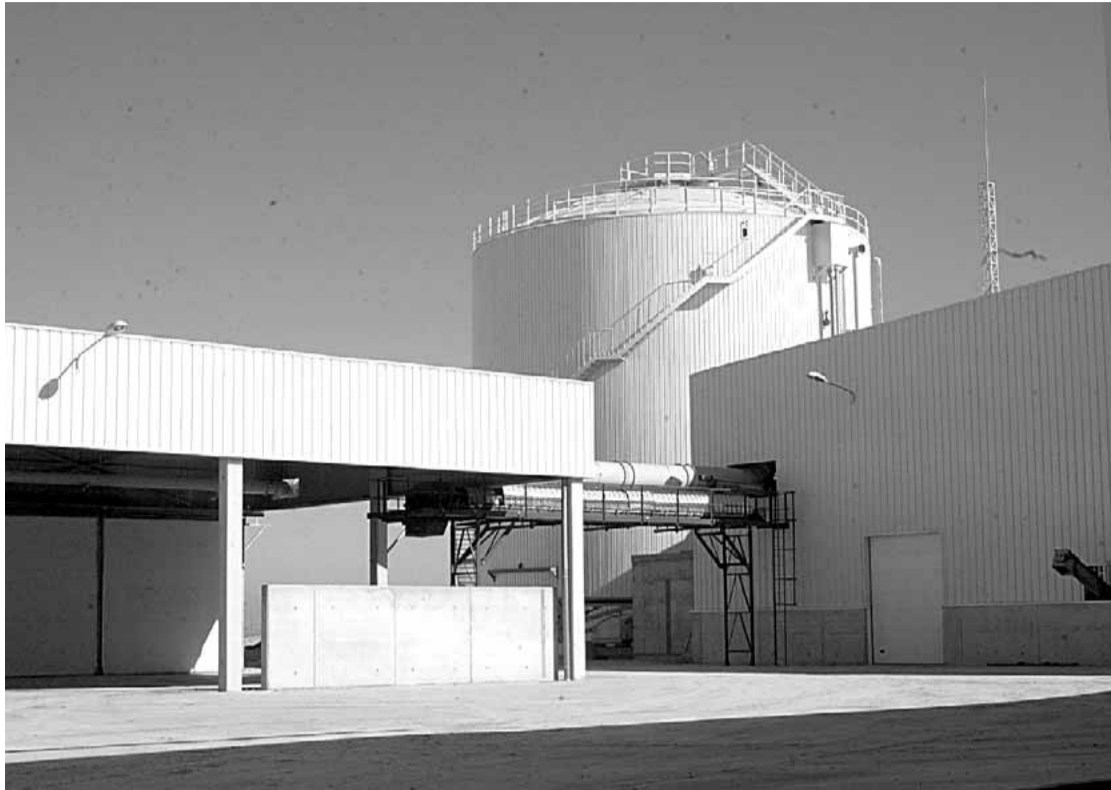
Instalaciones del nuevo Centro de Tratamiento de Residuos de Valdeseñor. / J. RUIZ
