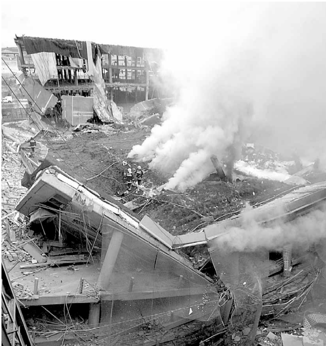
DESTROZOS. La explosión en Barajas causó el derribo del edificio. / PEDRO ARMESTRE-AFP
