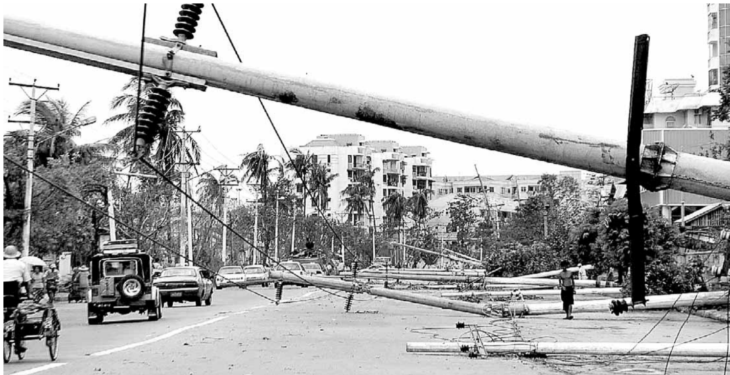
Postes de un tendido eléctrico totalmente destrozado por el ciclón 'Nagris' en una avenida de Yangon. / K. MAUNG WIA-AFP
